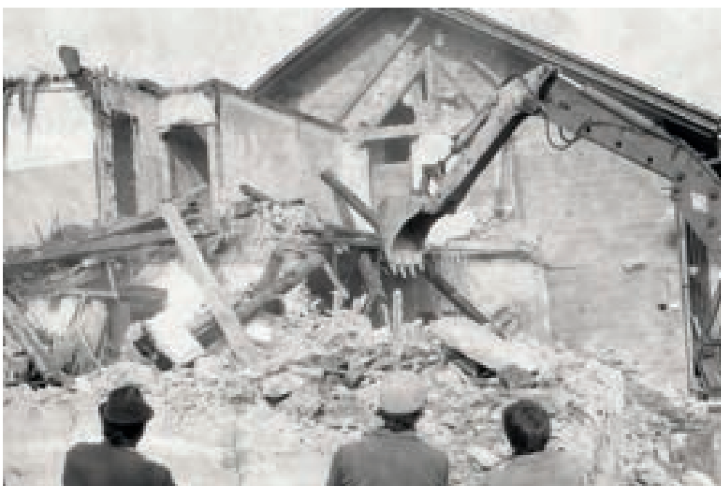
Gradnja kulturnega doma v Šentjoštu
