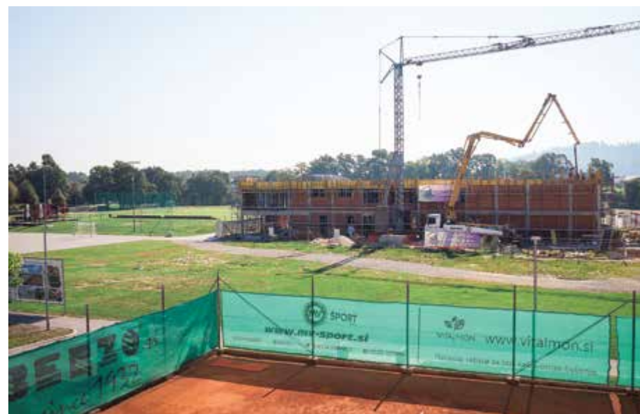
Vrhnika bo bogatejša za nov športni park; zdaj gradijo garderobne objekte, sledili bodo še drugi.
